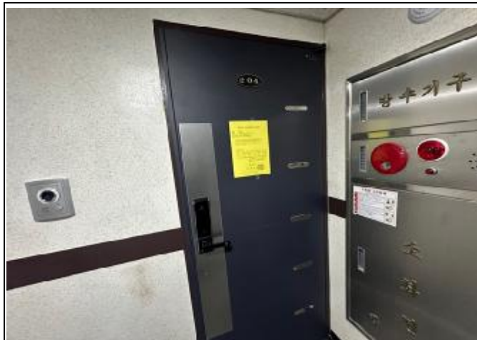
기호 다) 출입문 촬영
