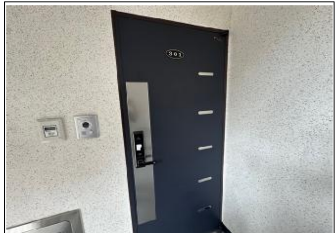
기호 라) 출입문 촬영
