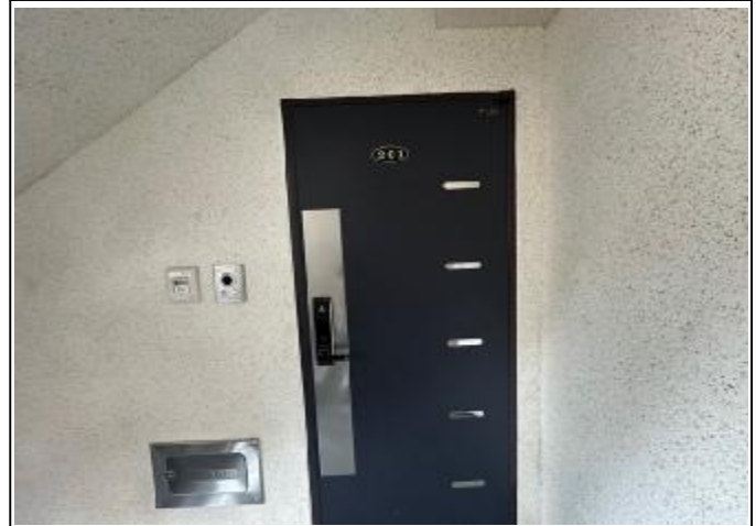
기호 나) 출입문 촬영
