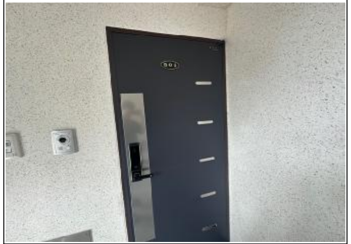
기호 타) 출입문 촬영
